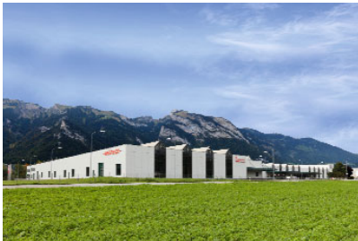
Heizsystemeproduktion in Sennwald CH
