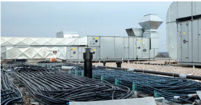
65 Kollektoren auf dem Dach entziehen Sonne und Luft die Wärme.
