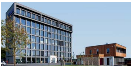
Die Kampa Firmenzentrale wurde komplett aus Holz gebaut.
