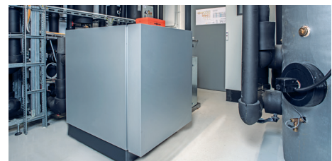
Wärmepumpe Vitocal 300-G Pro mit 82,8 kW Leistung im Neubau des Kreishauses Rendsburg
