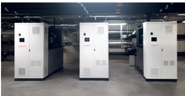
Die Viessmann Großwärmepumpen haben eine Leistung von jeweils 520 kW.
