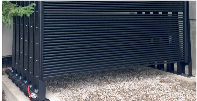
Solar-Luftabsorber in Form eines Energiezauns. Die kompakte Anordnung der einzelnen Module benötigt nur wenig Platz.
