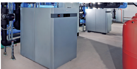
2 Wärmepumpen Vitocal 300-G Pro mit je 120 kW Leistung, im Hintergrund 1 Gas-Brennwert-Spitzenlastkessel Vitocrossal 300.
