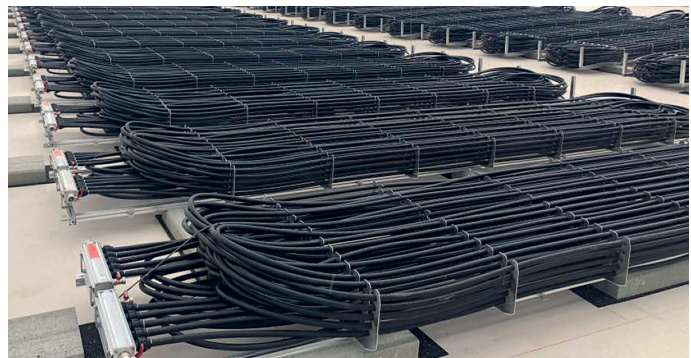
Einsatz auf dem Flachdach: Solar-Luftabsorber
