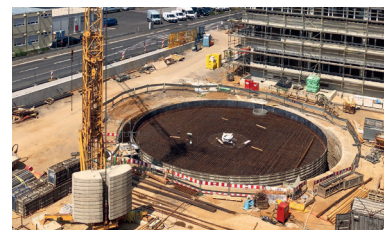
Bau des Eis-Energiespeichers mit einem Durchmesser von 10 m
