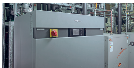
Wärmepumpe Vitocal 300-G Pro mit 82,8 kW Leistung im Neubau des Kreishauses Rendsburg
