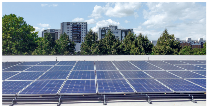
Thermische und elektrische Energie können mit einem speziellen PVT-Modul auf ein und derselben Fläche gewonnen werden.
