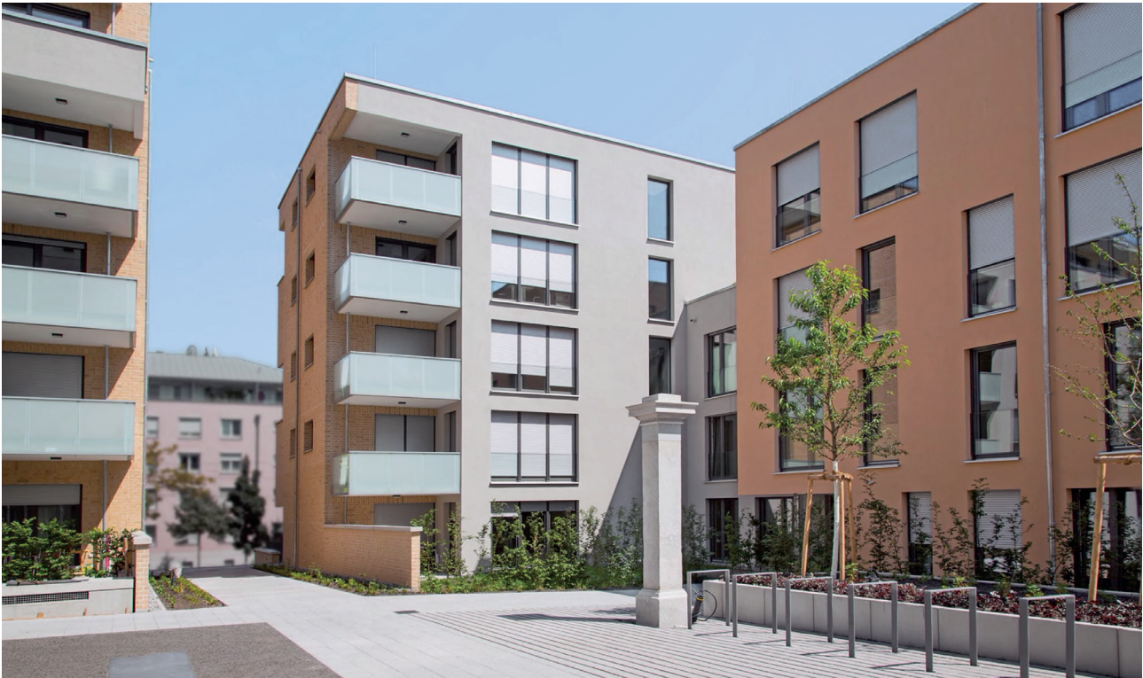
Das Rosensteinquartier in Stuttgart: 470 Wohnungen wurden hier nach dem Prinzip der Sektorkopplung umgesetzt.
