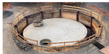
Eisspeicher in der Endphase des Baus. Sein Fassungsvermögen beträgt 350 m 3 .
