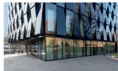
In die Fassade des Blauhauses wurden PV-Module integriert.
