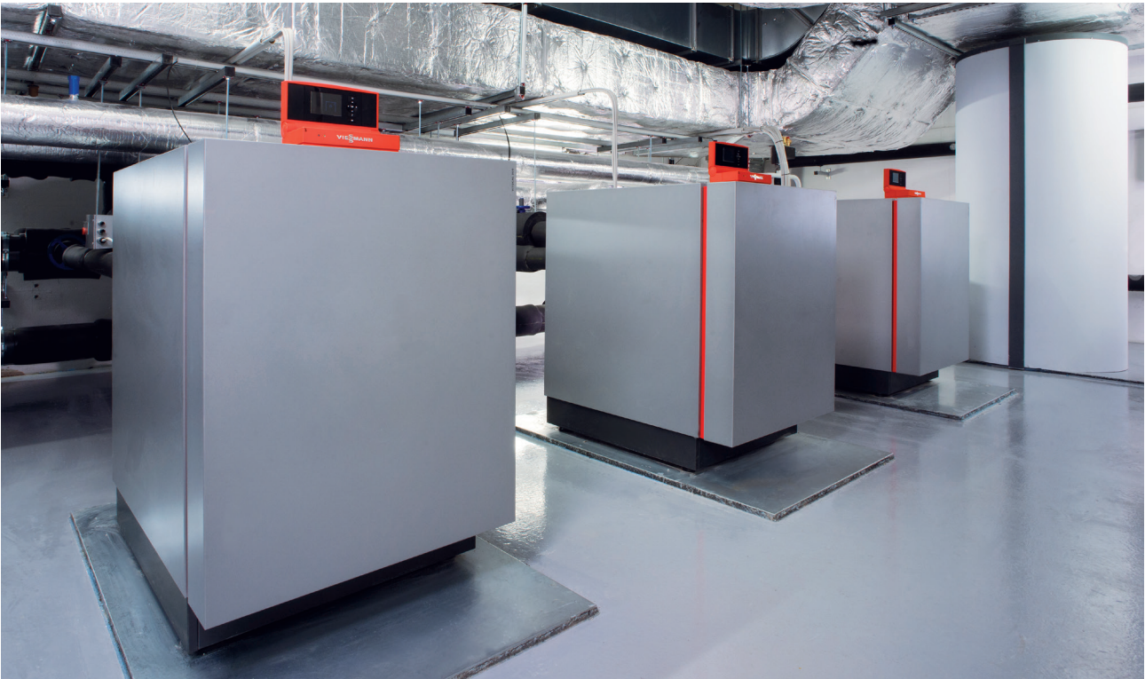
Wärmepumpen Vitocal 300-G Pro
