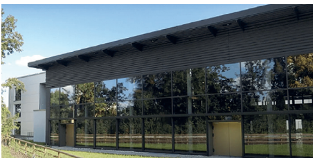
Ausgezeichneter Neubau des Berufsschulzentrums Mühldorf am Inn mit Viessmann Technik.
