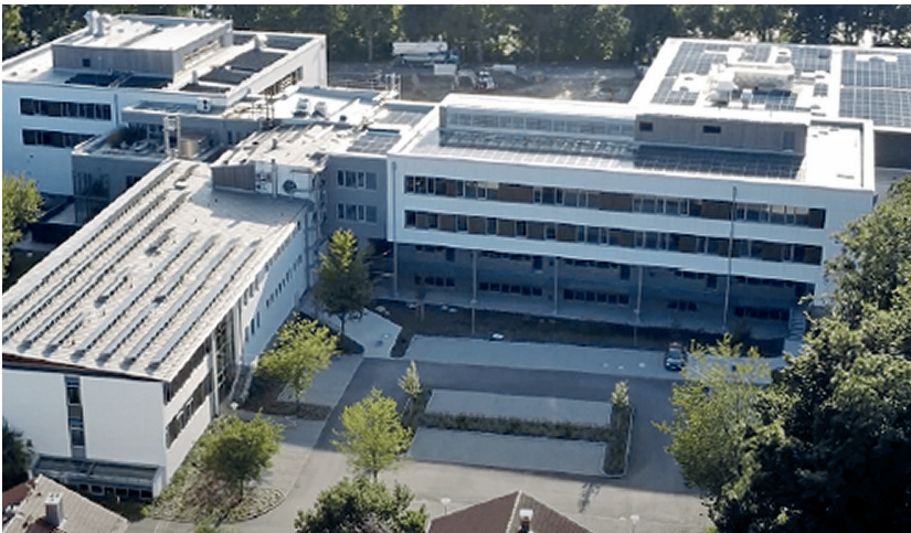
Berufsschulzentrum Mühldorf am Inn
