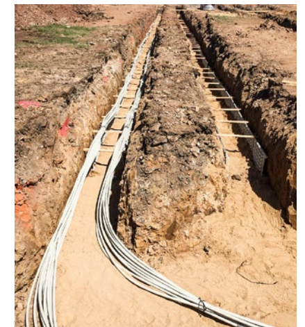
Die Vorläufe auf der einen und die Rückläufe auf der anderen Seite: Sie werden oberhalb der Kollektoren fixiert.
