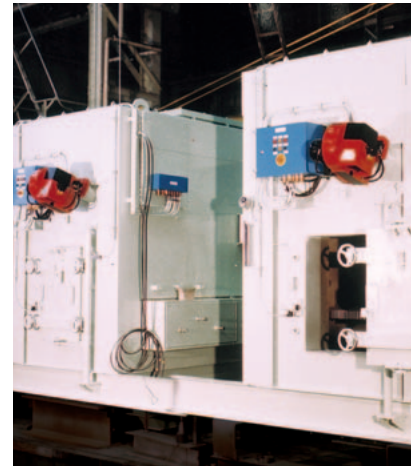
Müllverbrennungskessel auf dem Luxusliner „MS Empress“ mit zwei L1 Brennern
