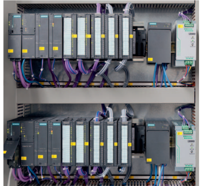
Höchste Sicherheit auch durch redundante Steuerungen
