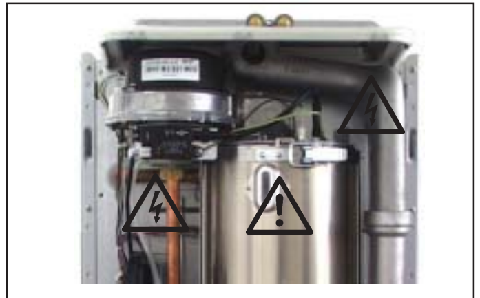
Bild: Zündtrafo, Hochspannungs-Zünder, Brennkammer Gefahr durch elektrische Spannung, Gefahr von Verbrennung durch heiße Bauteile
