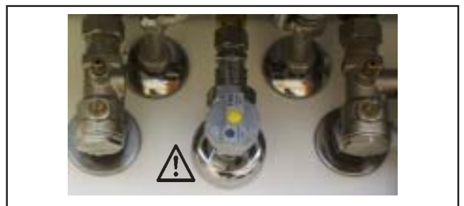
Figura: attacco gas: pericolo di intossicazione e di esplosione per fuoriuscita di gas
