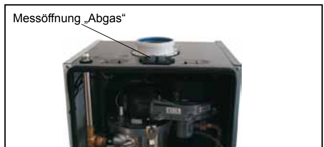
Bild: Abgasmessung bei geöffnetem Gerät
