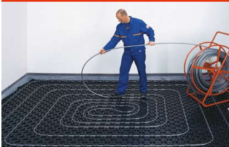
Abb. 9: Vitaset System-Heizrohr auf Noppenelemente verlegen
