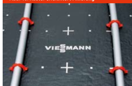
Abb. 18: Raster erleichtert Fixierung
