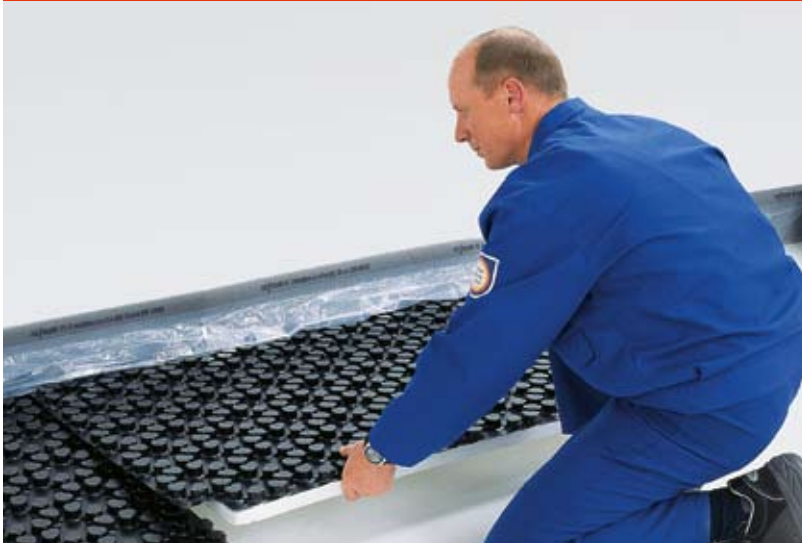
Abb. 5: Elemente formschlüssig verlegen
