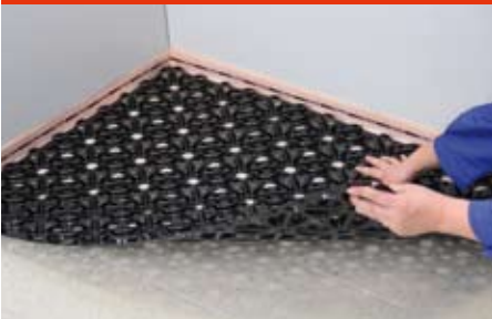
Abb. 28: Erste Systemplatte anlegen
