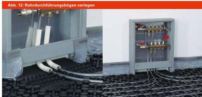
Abb. 12: Rohrdurchführungsbögen verlegen
