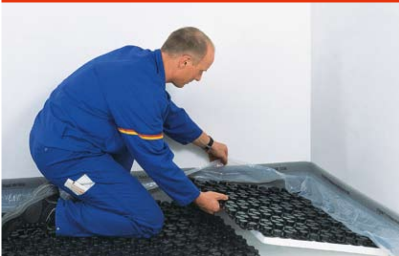
Abb. 6: Noppenelement auf Maß schneiden
