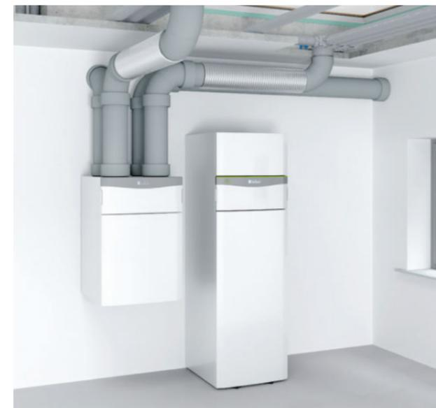
Zentrale Lüftung mit flexiblem Luftkanalsystem
