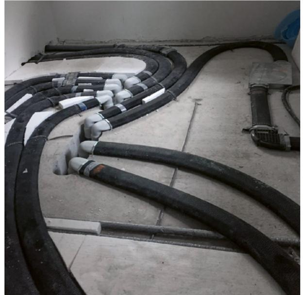
Durch den R90-Rundkanal am Verteilerkasten können die Kanäle variabel und drehbar aus dem Deckendurchbruch geführt werden.
