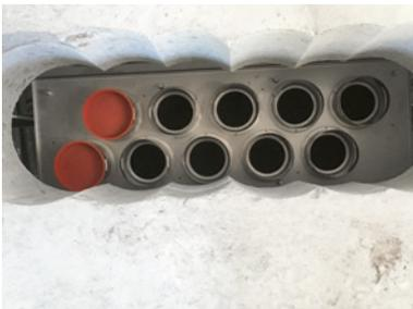
Deckendurchbruch mit darunter liegendem Verteilerkasten inkl. Anschlussstutzen R90
