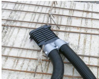
4. Nach erfolgter Rohmontage wird der Verteilerkasten an der Anschlussplatte montiert. Somit ergibt sich optisch eine perfekte Installation.
