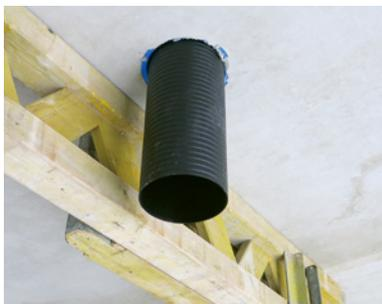
3. Anschließend werden die Rundrohre auf der Decke bzw. unter der Bewehrung verlegt und mittels Kabelbinder in einem Abstand von circa einem Meter fixiert. Nicht benötigte Anschlüsse sowie Rohrenden werden mit Verschlusskappen verschlossen. Zum Abschluss werden die Stützen in der Fertigmontage deckenbündig gekürzt und die Ventile eingesetzt.
