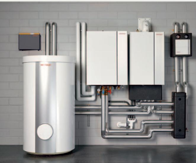
*Hybridanlage bestehend aus Gas-Brennwertgerät und Split-wärmepumpe.*
