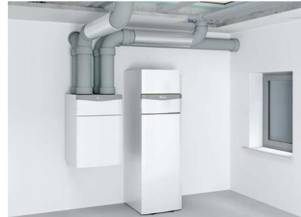
Zentrale Lüftung recoVAIR 260 mit flexiblem Luftkanalsystem
