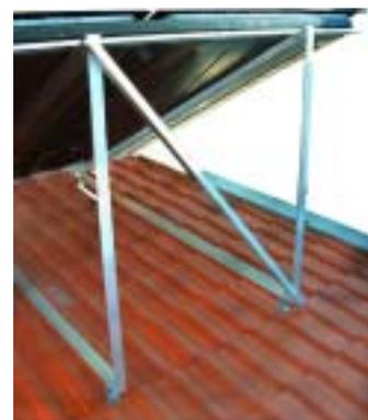
**Achtung** Aus Sicherheitsgründen muss unter der Kollektorfläche nach dem Regelwerk des Dachdeckerhandwerkes eine überdeckte Unterdeckung mit Bitumenbahnen vorhanden sein oder sonstiges geeignetes Material, um bei eventuellen Undichtigkeiten das Eindringen von Feuchtigkeit in das Gebäude zu verhindern. Dieses muss in der Dachrinne enden.
