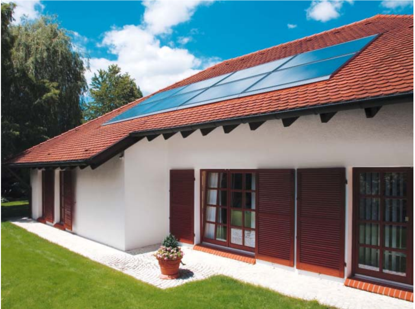
Kollektoranlage zur kombinierten Trinkwassererwärmung und Heizungsunterstützung
