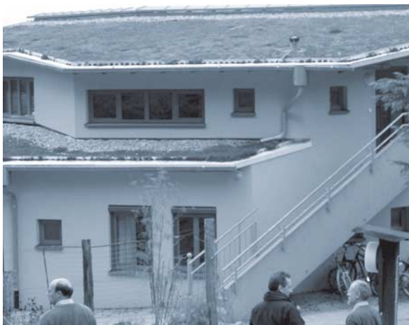
Erweiterungsbau mit extensiv begrüntem Dach, Retentionswert 50 %
