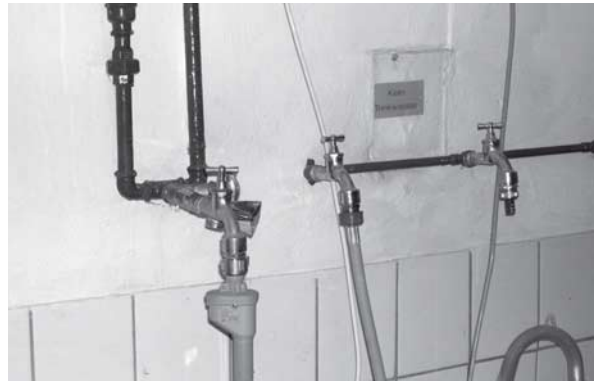
Abb. 1: Separate Entnahmestellen für Waschwasser links Trinkwasser, rechts Zisternenwasser
