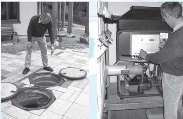
Platz mit den Schachtabdeckungen von unterirdischem Filter und Zisterne (links). Technikraum mit Druckerhöhungsanlage und Regenwasserverteiler zu WC, Waschmaschine und Bewässerungsstellen (rechts).
