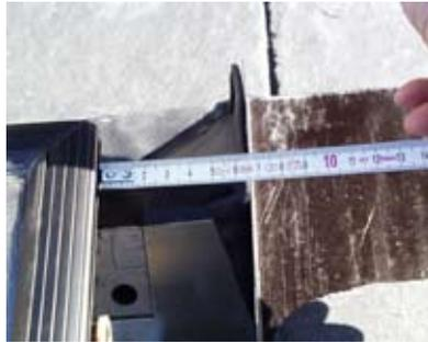
Alle Schichtstücke / Nocken auf 65 mm ausrichten und jedes Mal mit 2 Nägeln befestigen (oben)
