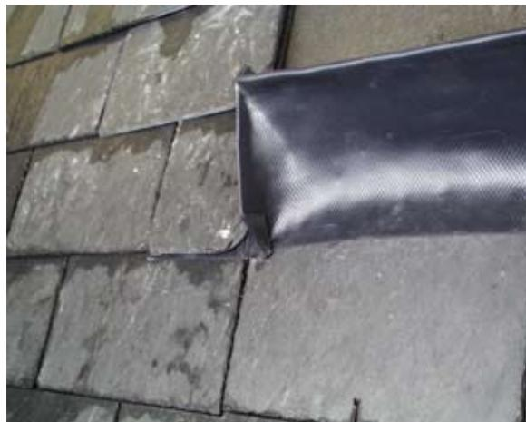
Schichtstück / Nocken an Falte anpassen, gegebenenfalls mit Schere ablängen
