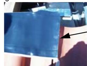
Mit  $\varnothing$  5mm vorbohren und Montageschiene mittels beiliegender Schlüsselschrauben 8x80 zusammen mit Holzdistanzstücken (Dachlattenstärke abzüglich 9 mm) am Sparren befestigen.
