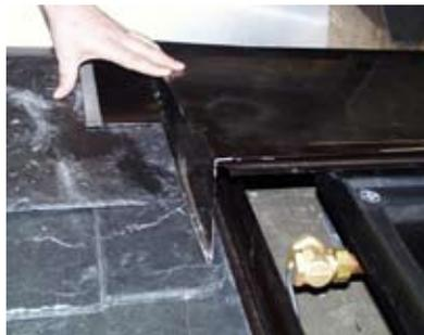
Höhenunterschied unter Berücksichtigung von Schieferstärke, Dachneigung und Überlappung des Schiefers berechnen: Maß X
