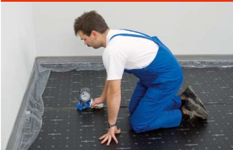
Abb. 16: Stoßkanten mit Klebeband abkleben
