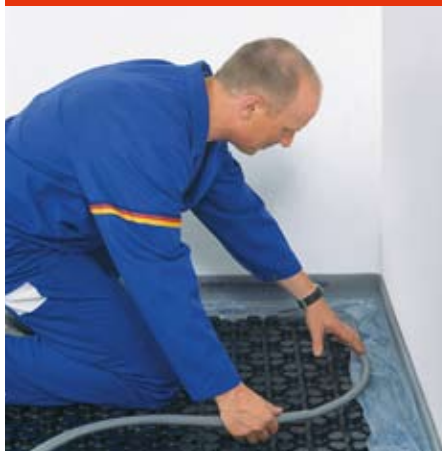
Abb. 8: PE-Rundprofil verlegen
