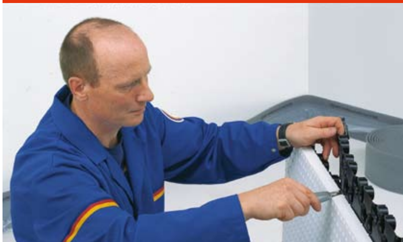
Abb. 3: Folienüberstand des Noppenelements abschneiden
