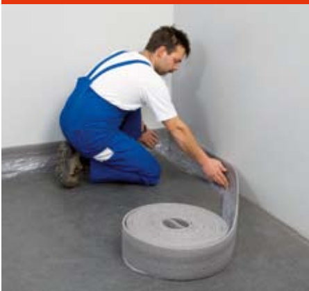
Abb. 14: Randdämmstreifen verlegen
