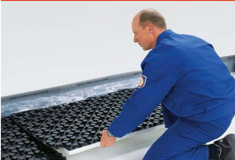
Abb. 5: Elemente formschlüssig verlegen
