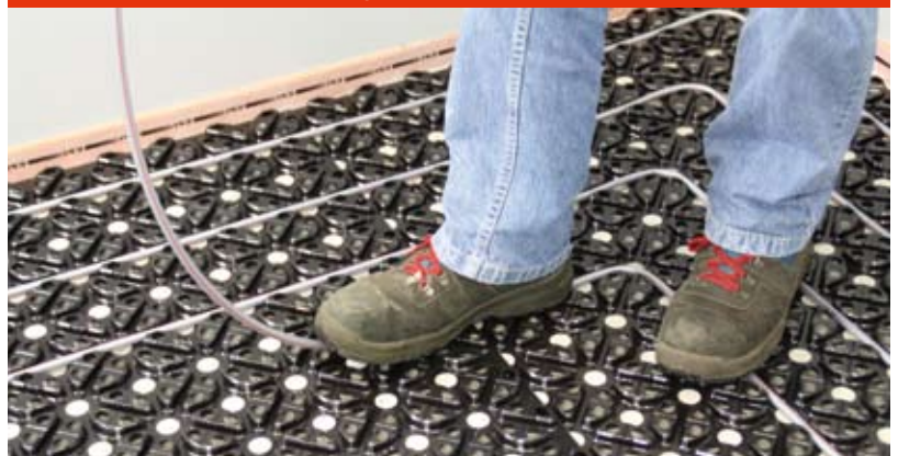
Abb. 30: Vitaset Sicherheitsrohr verlegen
