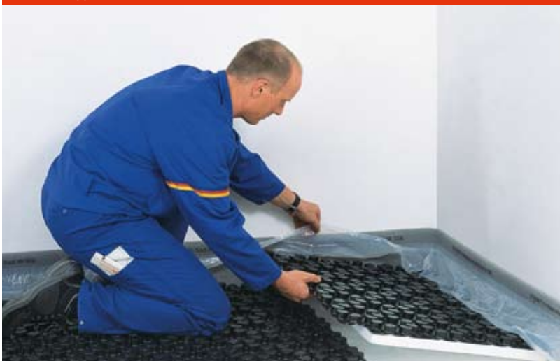
Abb. 6: Noppenelement auf Maß schneiden
